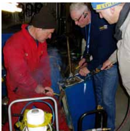
Här håller Robban H och Stefan H på med att rikta plåt på gavlarna på den av Robban nysvetsade batterikåpan på slamkrypare 1.
